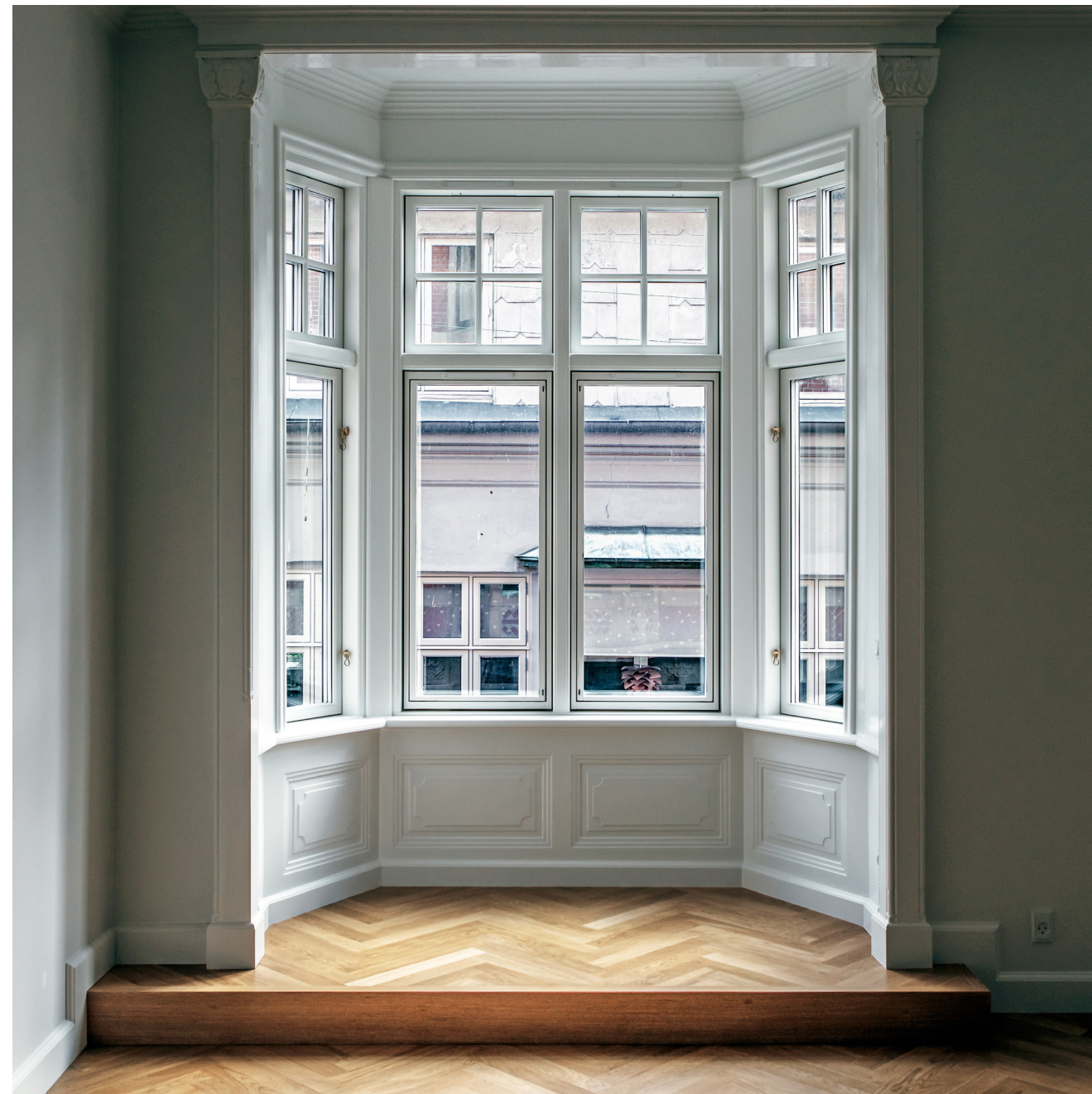
Karnappen lader en masse lys komme ind i lejligheden og sammen med de andre vinduer giver den en god dynamik både udenfor i facaden - men også indenfor i lejligheden, hvor den med sine høje paneler understreger den herskabelige stemning.
